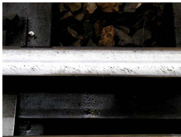
Slika 5. Posebno oštećenje na voznoj površini tračnice
