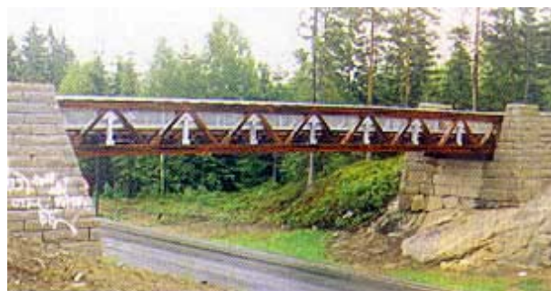
Slika 6. Nesoddvegen most, drveni rešetkasti pješački most
