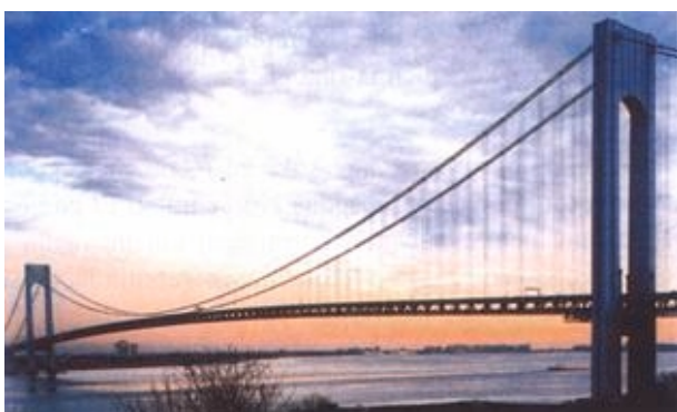
Slika 24. Pogled na most Verrazano-Narrows, dovršen 1964.
