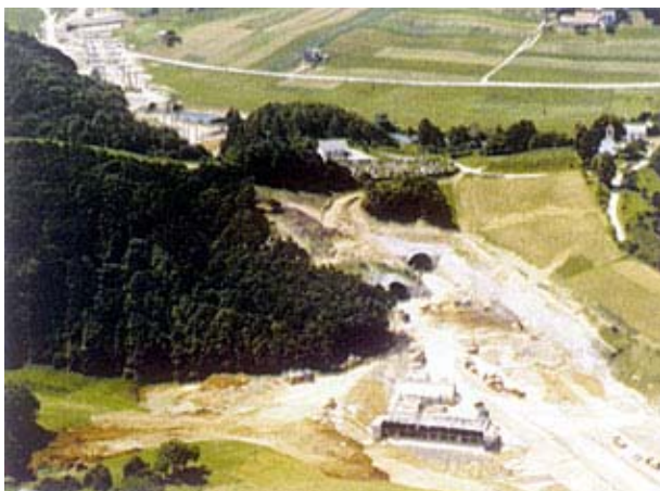
Slika 1. Gradilište tunela Sveti Marko
