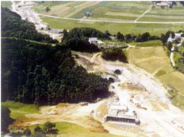
Slika 1. Gradilište tunela Sveti Marko
