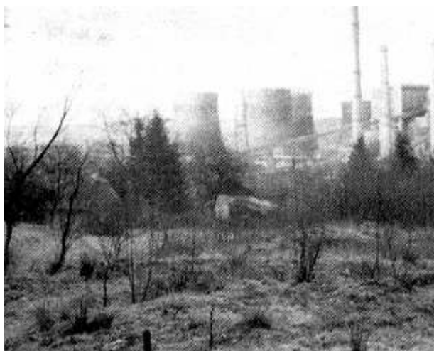
Slika 3. Pogled na sjevero-zapadni rub klizišta gdje se u pozadini vide objekti TE "Tuzla"
