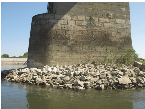
Slika 1. Riprap zaštita oko stupa mosta
