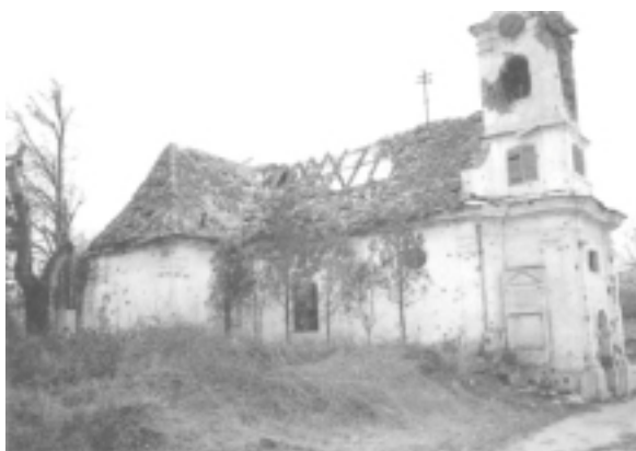
Slika 1. U domovinskom ratu oštećena kapela Sv. Roka u Vukovaru
