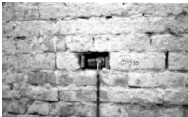
Slika 3. Način ispitivanja posmične čvrstoće morta zida od opeke
