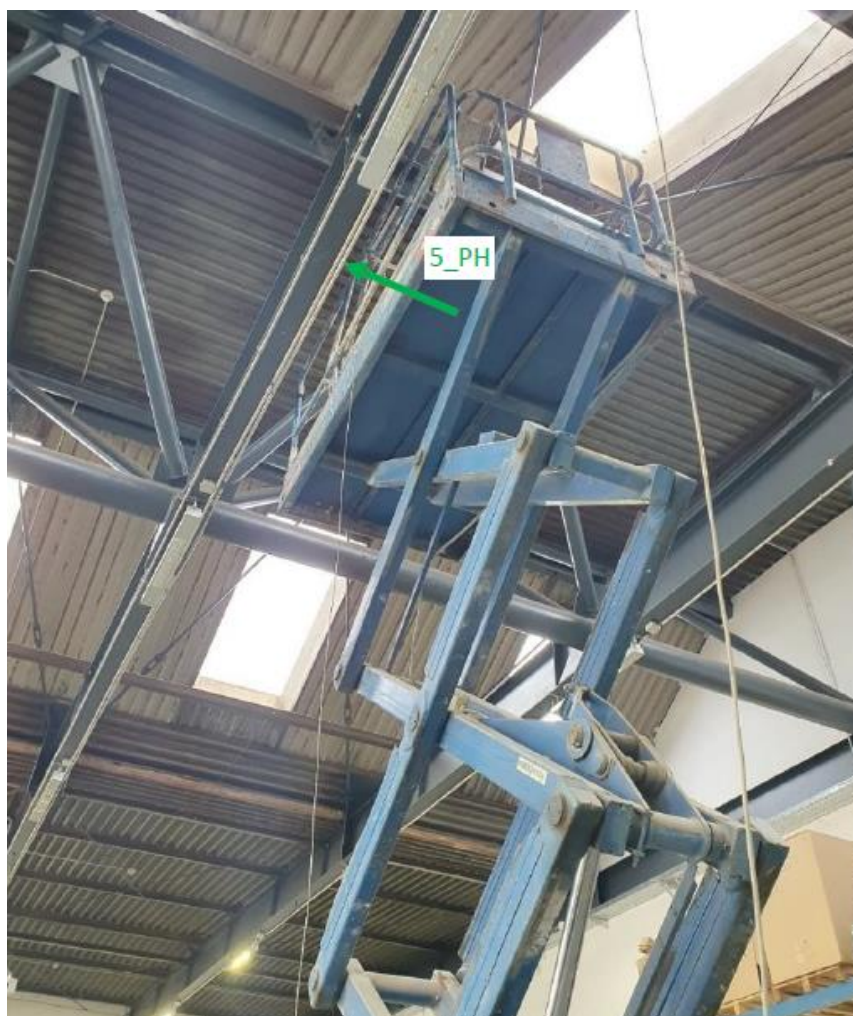
Slika 7.8 Pogled na osjetilo za mjerenje horizontalnog pomaka (hidraulična platforma je bila oslonac osjetila)
