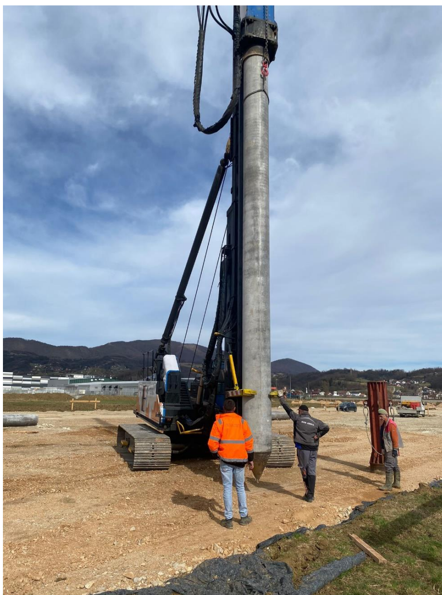
Slika 12 Junttan PM20 neposredno pred početak pobijanja
