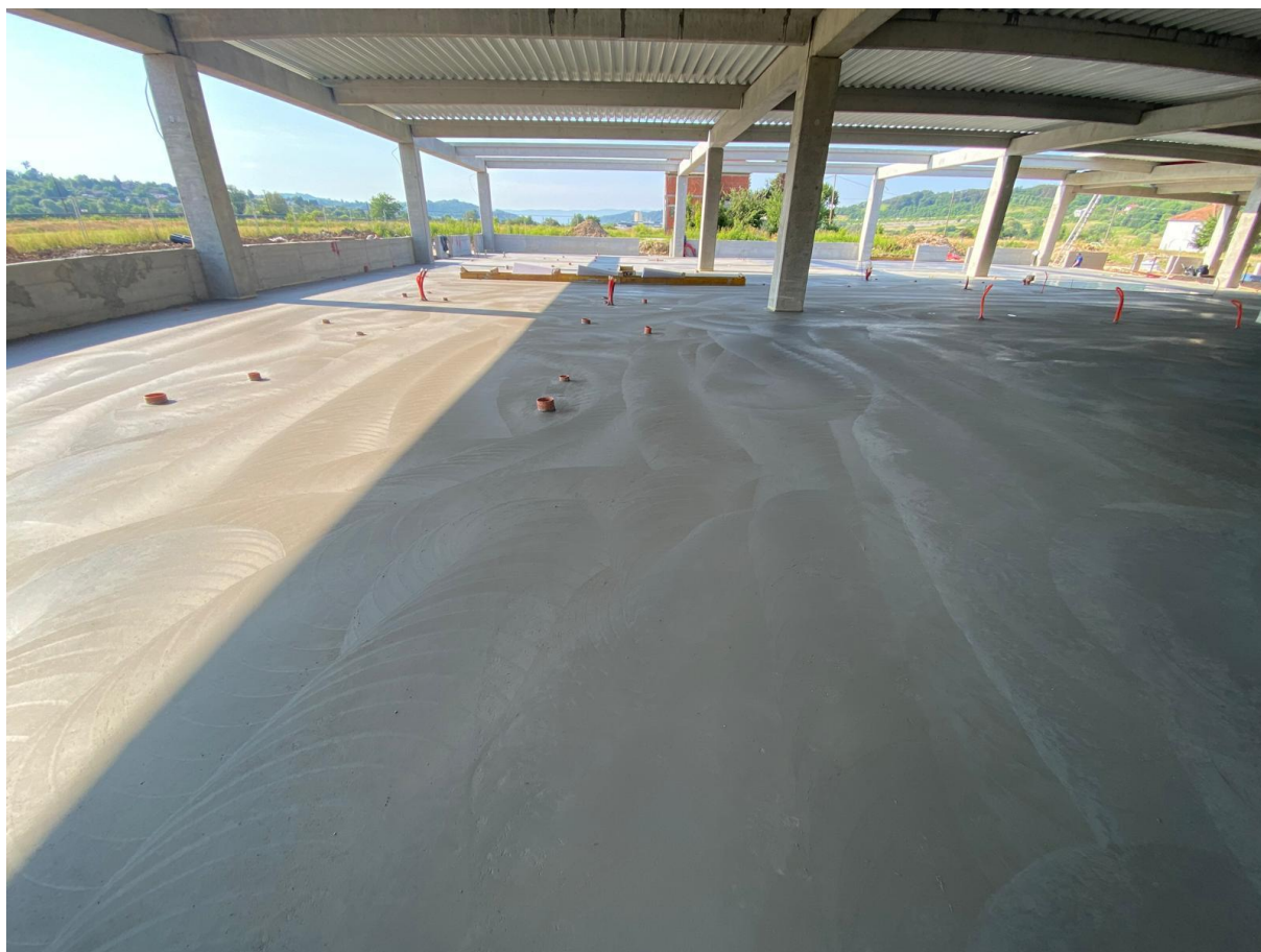
Slika 37 Podna ploča nakon završne obrade helikopterima.
