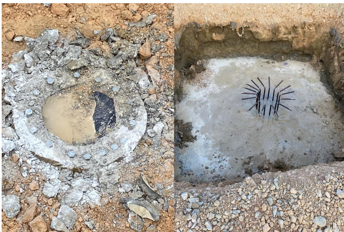
Slika 13 Zatvorene matice u vrhu pilota i ugrađene i savijene spojne šipke
