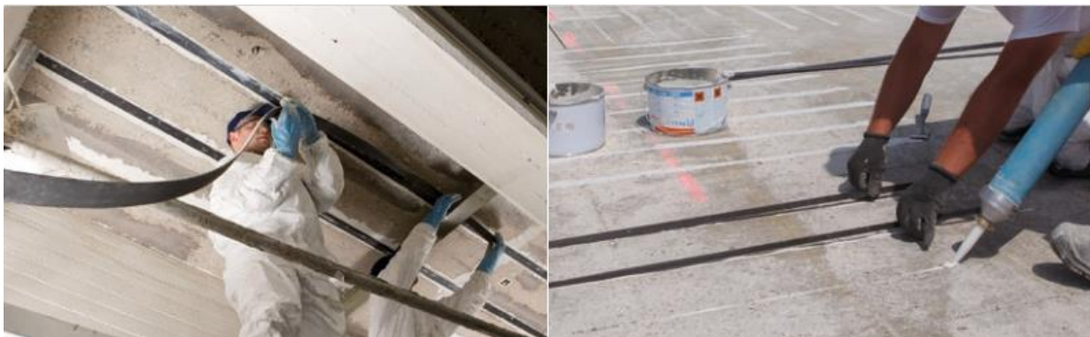
Slika 1. Lijepljenje CFRP lamela [6]
