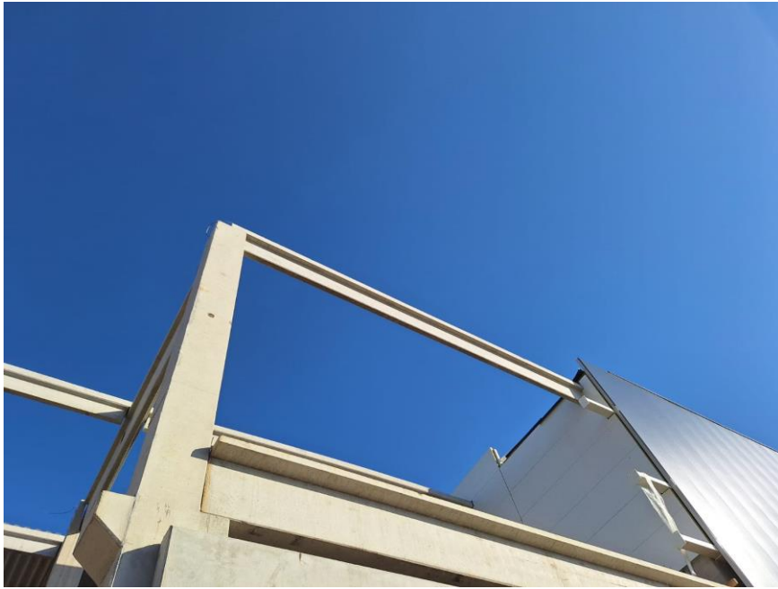
Slika 9: Ugrađena rubna greda
