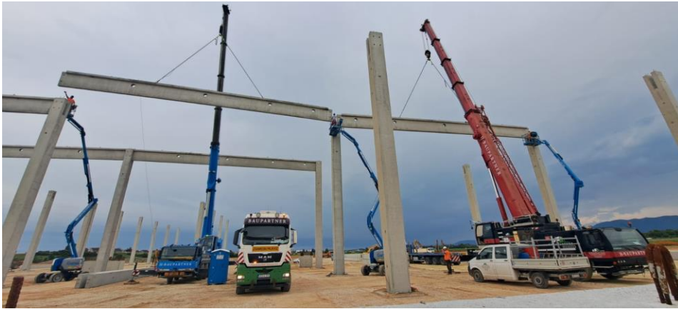
Slika 36: Montaža glavnih nosača
