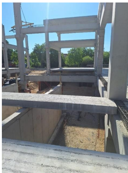
Slika 6: Šuplje predgotovljene ploče PPB300
