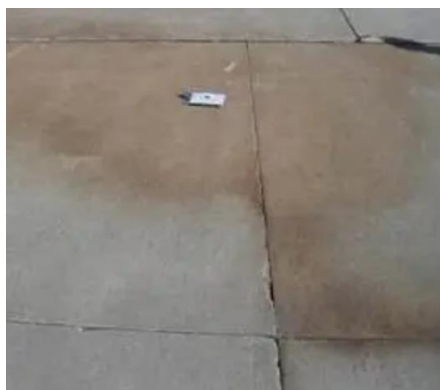
Slika 9. Promjena boje površine uzrokovana istiskivanjem vode [11]
