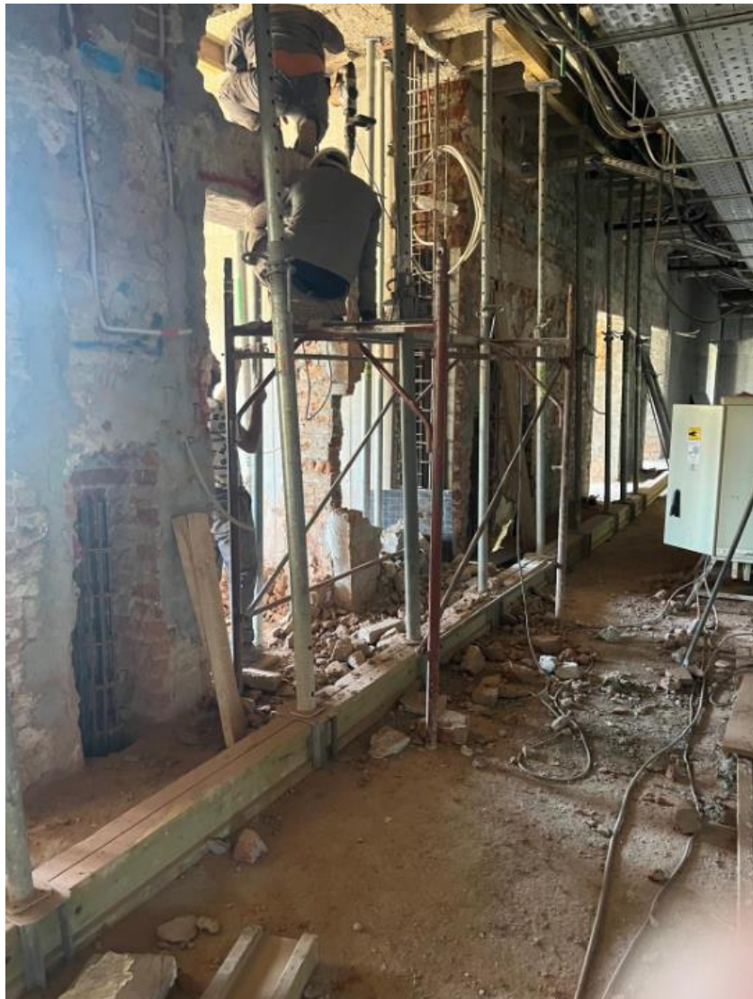
Slika 42.: Skela bez ograde i podnice
