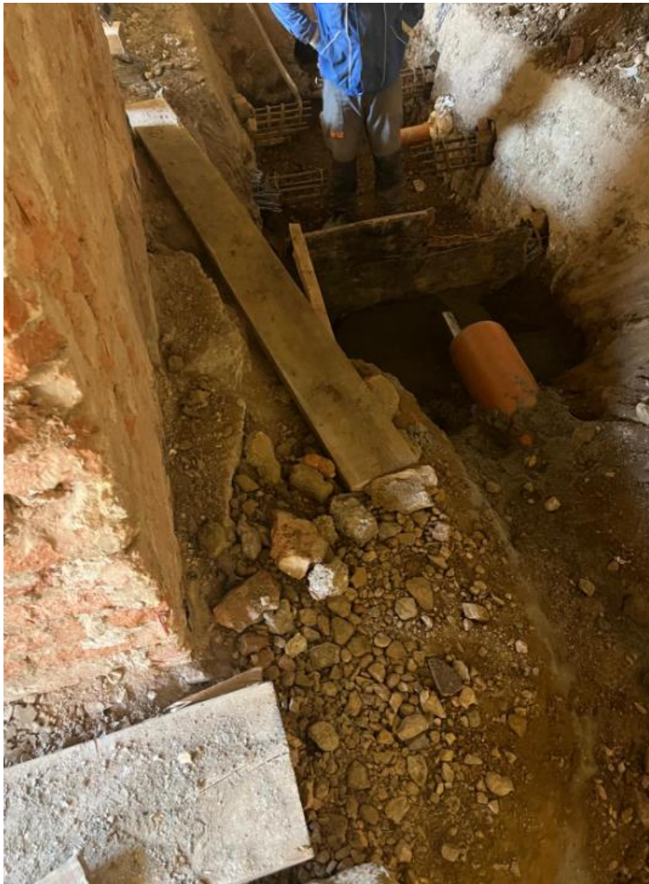
Slika 44.: Daska kao rampa za prijelaz
