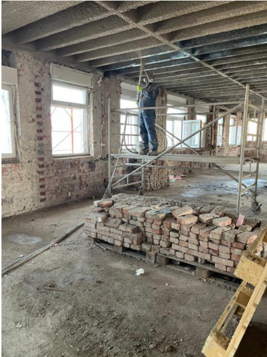
Slika 39.: Ispravno korištenje skela na kotačima
