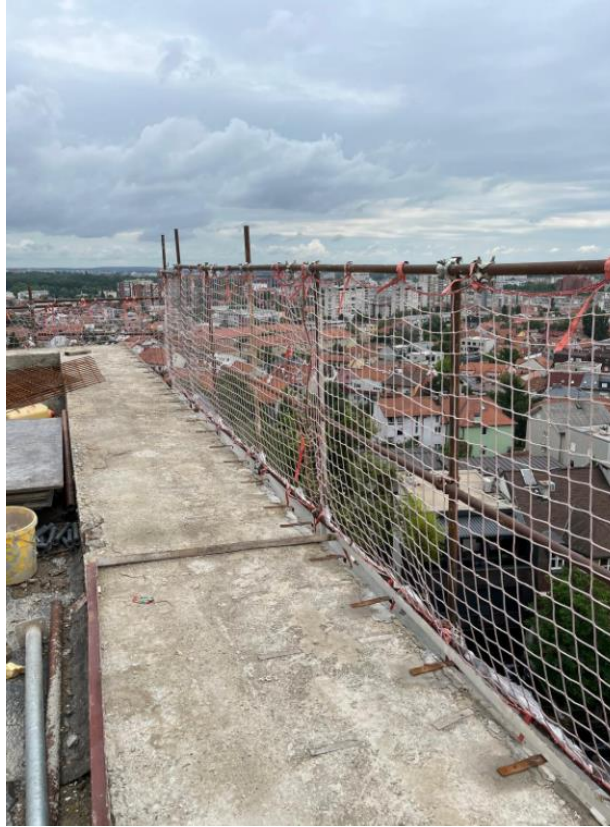
Slika 24.: Ograda na južnom dijelu krova
