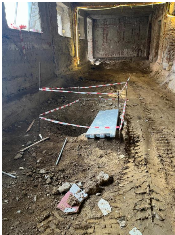
Slika 31.: Traka za označavanje opasnosti
