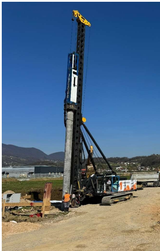
Slika 32. Pilot spreman za zabijanje
