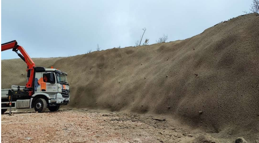
Slika 10. Zaštita pokosa mlaznim betonom
