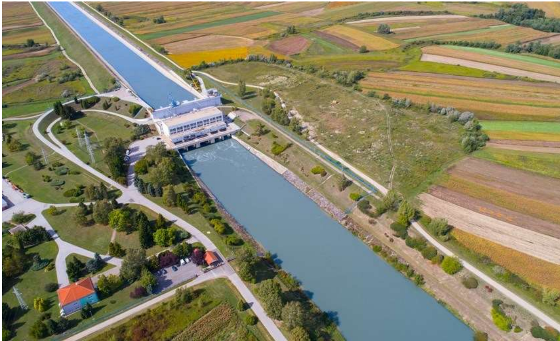
Slika 16.: Hidroelektrana Varaždin (HEP Proizvodnja, n.d. b)
