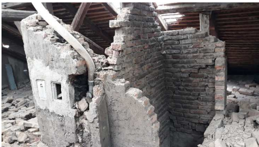
Slika 25: Južni svjetlarnik stradao u potresu 2020.
