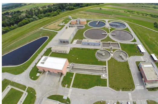
Slika 1: UPOV u Karlovcu s tri stupnja pročišćavanja (Izvor:[1])
