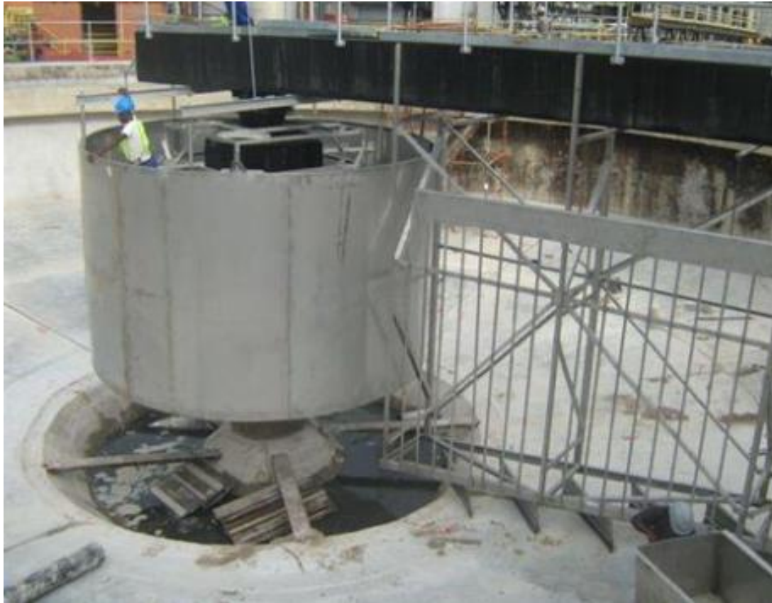
Slika 3: Zgušnjivač mulja (Izvor:[5])
