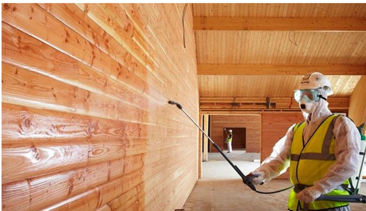
Slika 2.3.2 Primjena usporivača požara [54]
