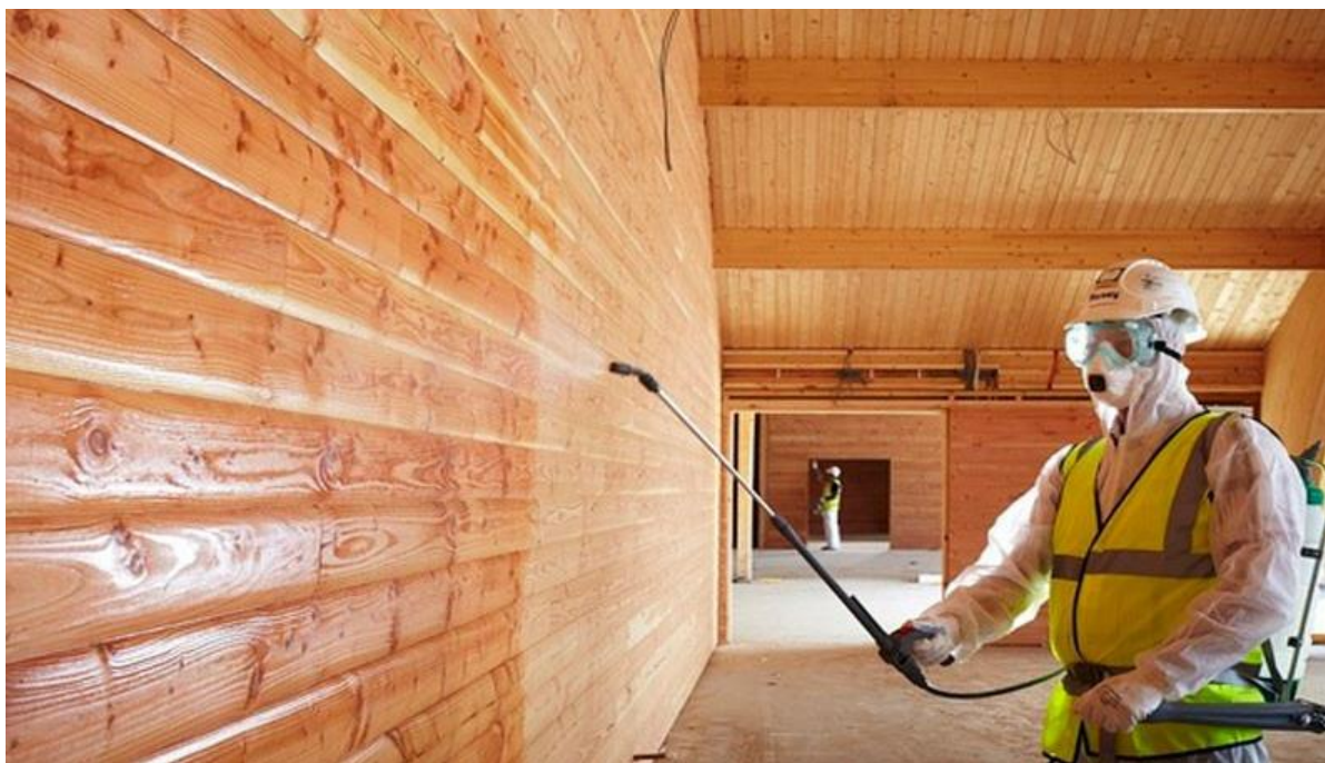
Slika 2.3.2 Primjena usporivača požara [54]
