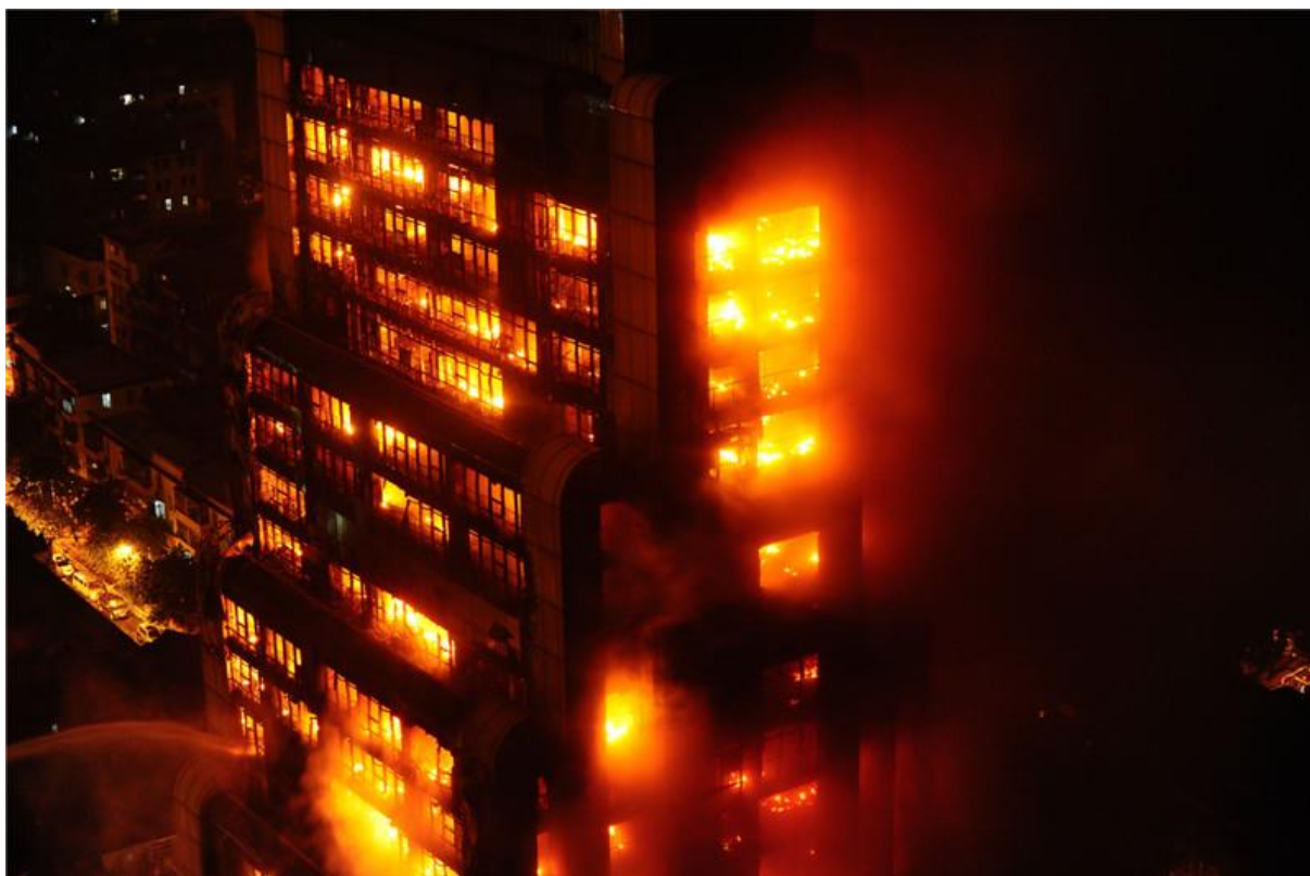
Slika 2.1.1 Zgrada prilikom požara [31]
