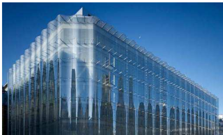
Slika 41: Novi dio zgrade (Izvor:[70])
