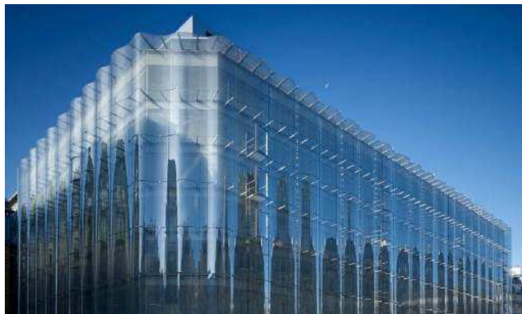
Slika 41: Novi dio zgrade (Izvor:[70])
