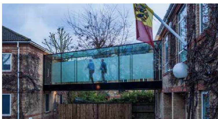
Slika 18: Primjer staklenog pješačkog mosta (Izvor: [31])
