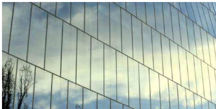
Slika 30: Primjer polustrukturalne obloge (Izvor: [54])
