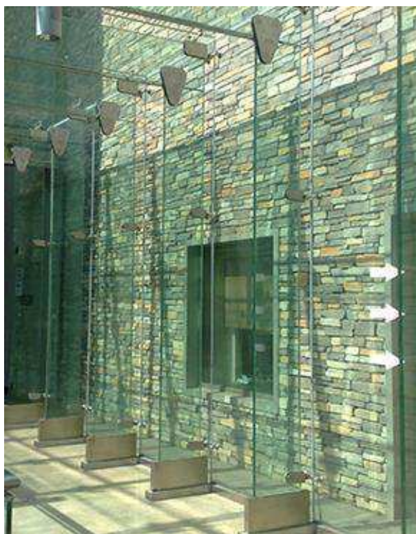
Slika 20: Stakleni stupovi (Izvor: [34])
