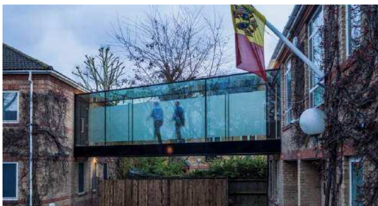
Slika 18: Primjer staklenog pješačkog mosta (Izvor: [31])
