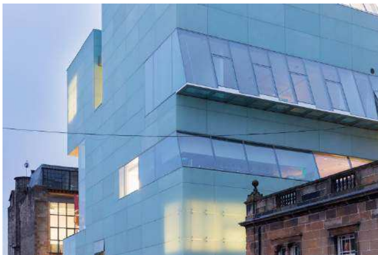
Slika 45: Seona Reid Building (Izvor: [75])
