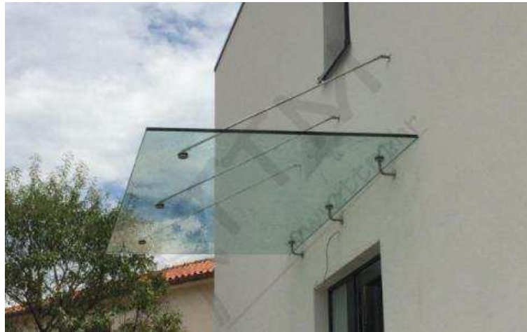
Slika 23: Točkasto oslonjena nadstrešnica (Izvor: [40])
