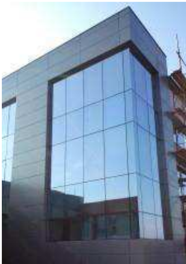
Slika 28: Primjer strukturalne obloge (Izvor: [51])
