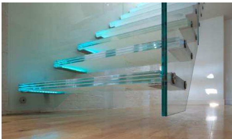
Slika 17: Primjer stakleninog stubišta (Izvor: [30])
