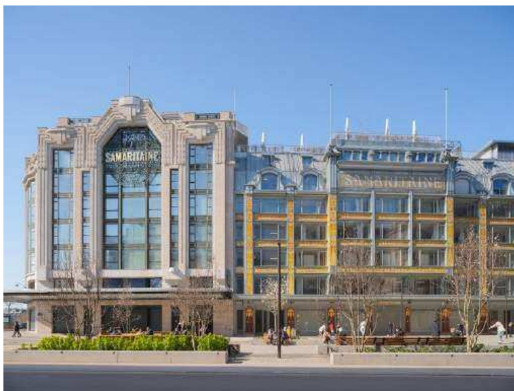
Slika 40: Stari dio zgrade (Izvor:[69])
