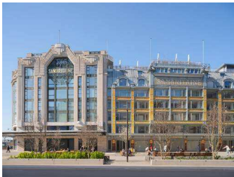
Slika 40: Stari dio zgrade (Izvor:[69])
