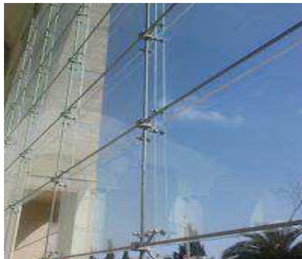
Slika 34: Primjer spider obloge (Izvor: [60])
