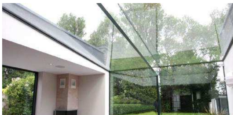
Slika 21: Staklene grede (Izvor: [35])
