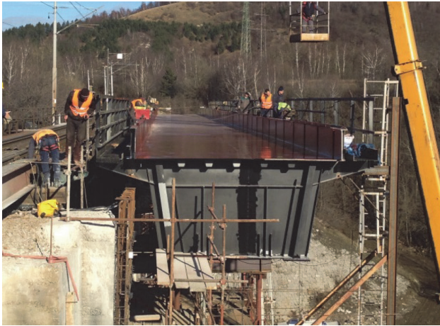
Slika 3. Čelična konstrukcija mosta, faza izvedbe
