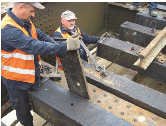
Slika 1. Pričvršćivanje drvenih pragova na čeličnu mosnu konstrukciju
