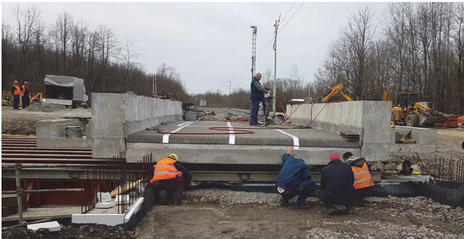
Slika 4. Armiranobetonska rasponska konstrukcija mosta, faza ugradnje postupkom naguravanja
