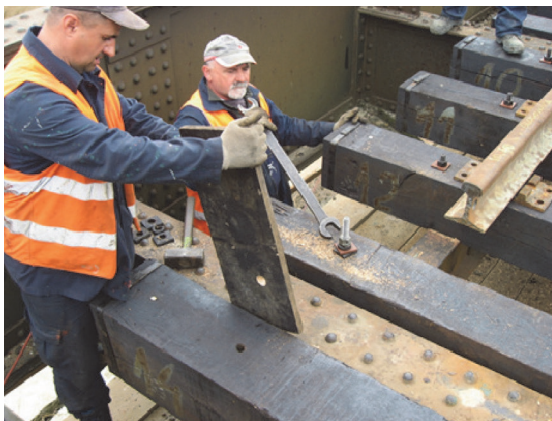
Slika 1. Pričvršćivanje drvenih pragova na čeličnu mosnu konstrukciju
