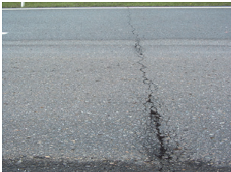
Slika 2. Izražajna strukturna pukotina [4]
