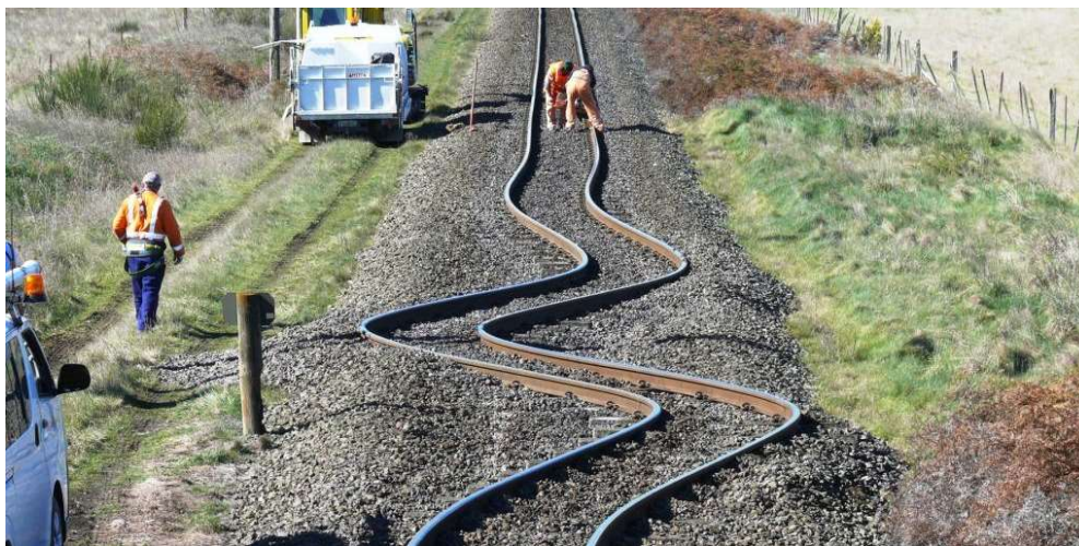
Slika 1: Izvijanje tračnica (Izvor: [1])
