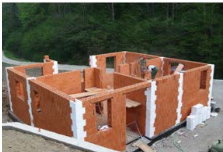
Slika 9.: Povezivanje zidanih zidova serklažima (Izvor: [13])
