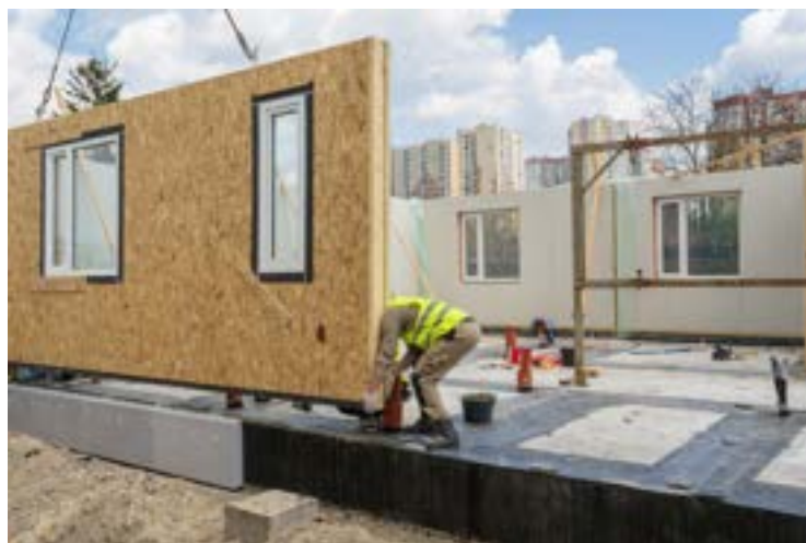
Slika 35.: Pozicioniranje montažnog elementa (Izvor: [42])
