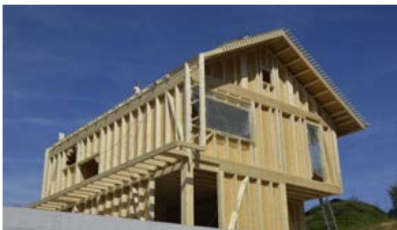
Slika 17.: Skeletna montažna gradnja s OSB pločama (Izvor: [26])
