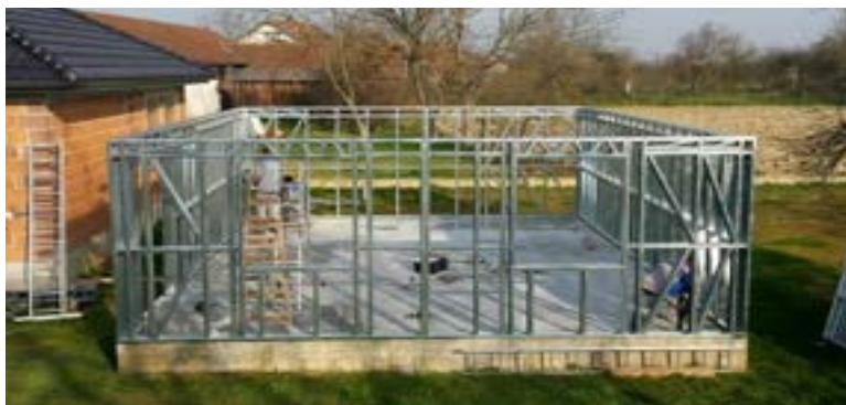
Slika 6.: Skelet čelične montažne kuće (Izvor: [9])
