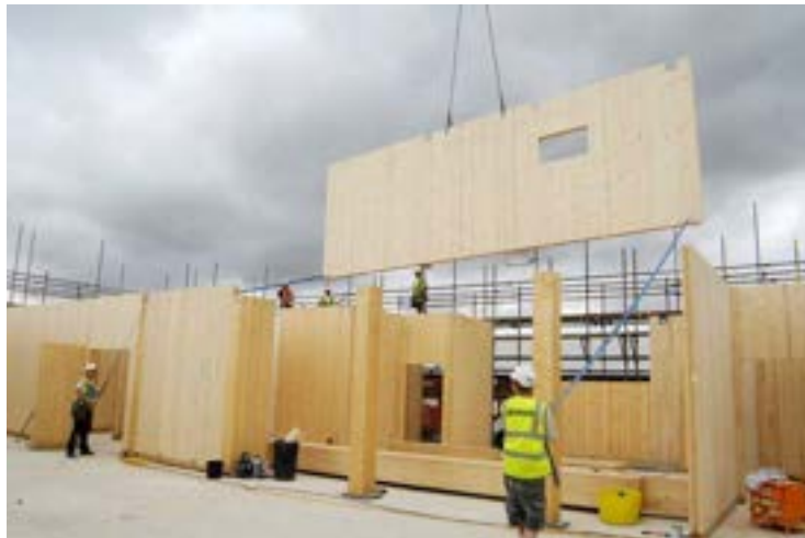
Slika 34.: Gradilišni transport elementa toranjskom dzalicom (Izvor: [42])
