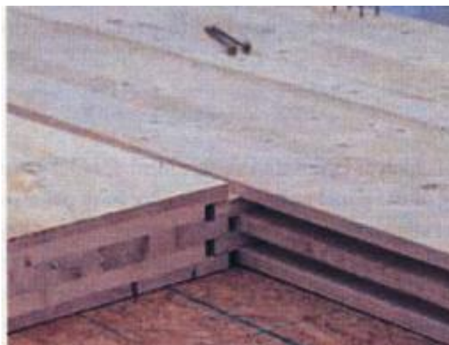
Slika 27.: Uzdužno povezivanje CLT elemenata (Izvor: [38])
