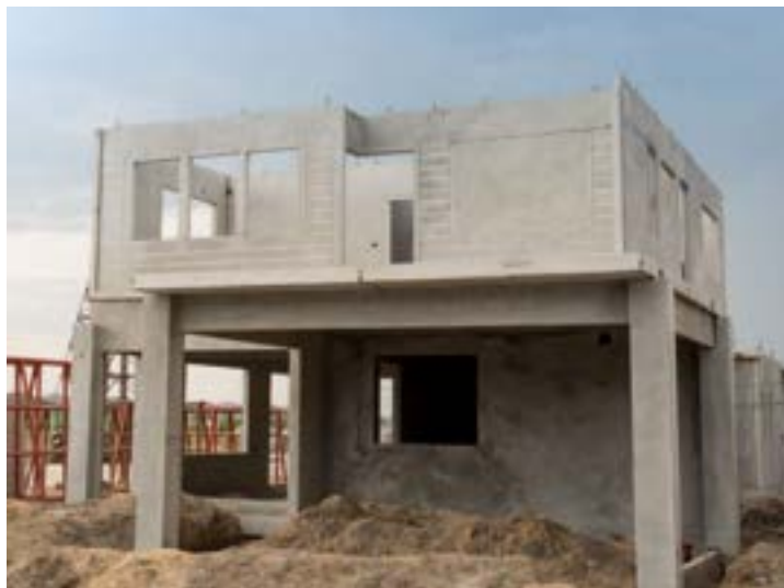
Slika 4.: Skelet betonske montažne kuće (Izvor: [6])
