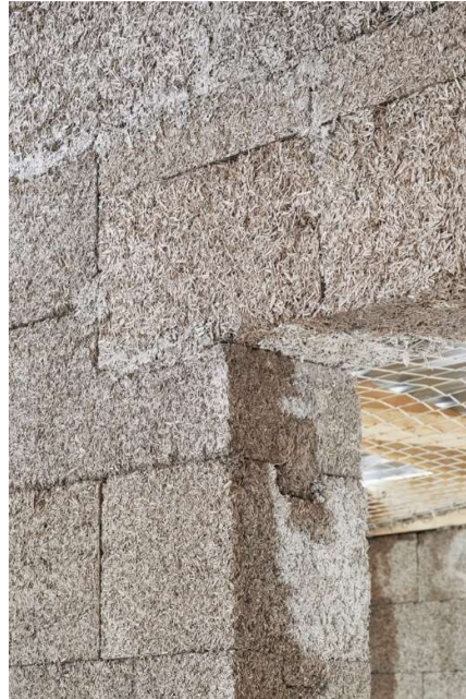
Slika 15: Hempcrete elementi od konoplje, Izvor: [55]
