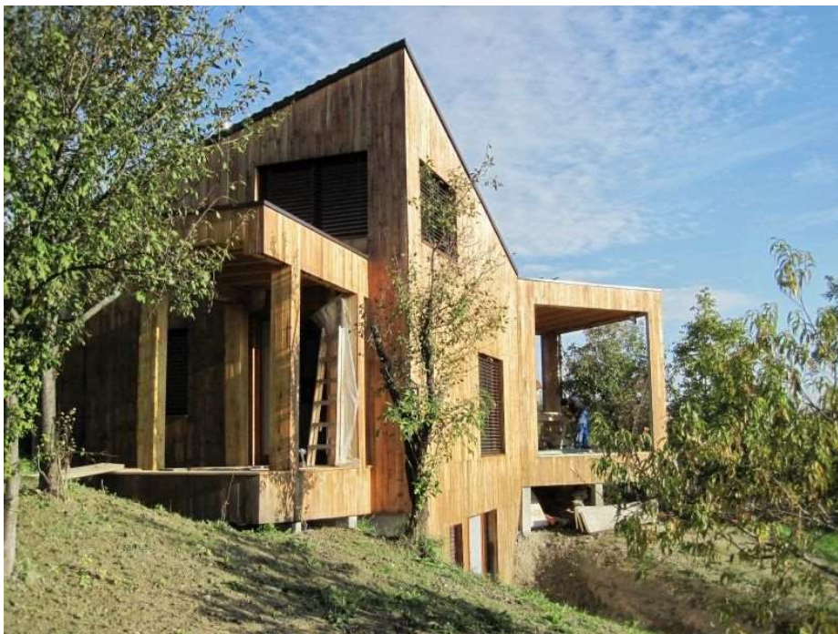
Slika 19: Građevina nakon završetka radova, Izvor: [58]
