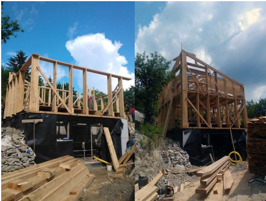
Slika 17: Drvena konstrukcija građevine, Izvor: [58]
