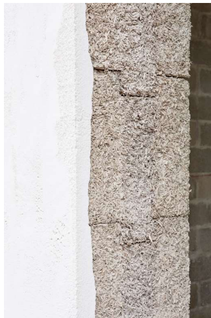
Slika 16: Završeni zidovi od konoplje, Izvor: [55]
