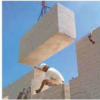
Slika 34: Kameni blokovi za izvedbu zidova (Izvor: [42])
