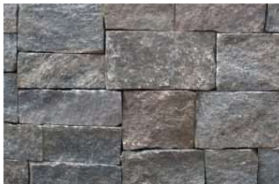
Slika 27: Primjer zida od grubo obrađenog kamena (Izvor: [39])
