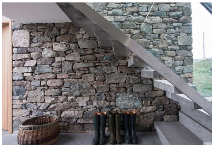
Slika 19: Primjer zida od pločastog kamena (Izvor: [31])
