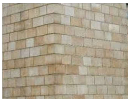
Slika 29: Primjer zida od fino obrađenog kamena (Izvor: [40])
