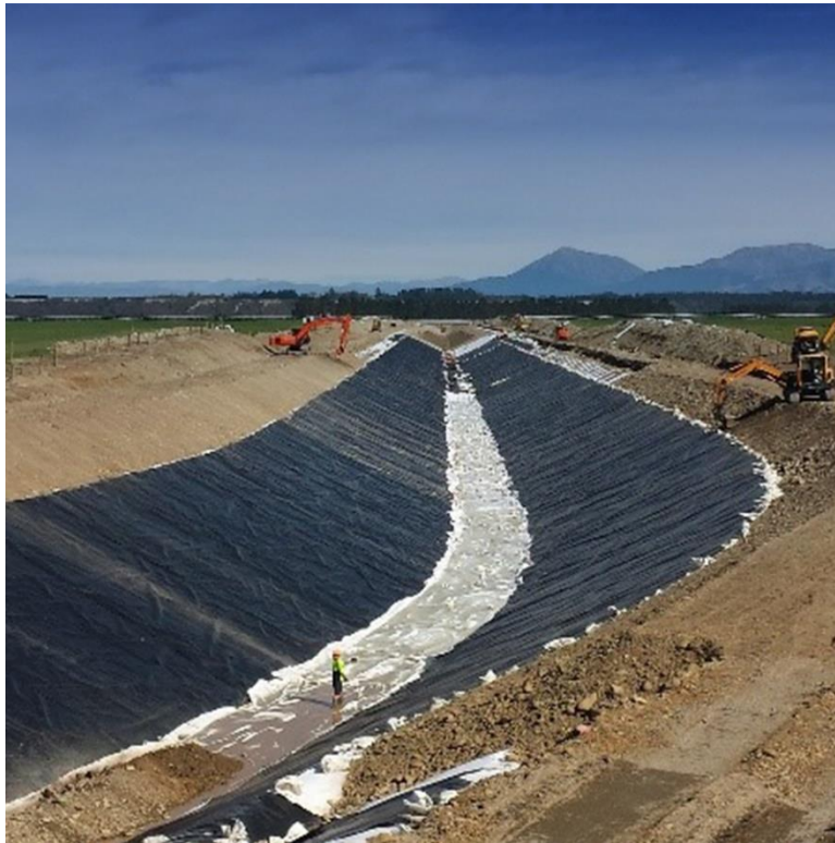
Slika 11. Obloga od plastične sintetičke folije [6]
