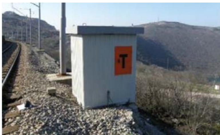
Slika 11. Prikaz APB kućice. [24]
