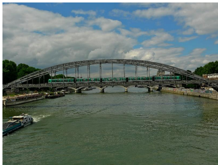
Slika 3.5. Viaduc d'Austerlitz, Pariz [11]
