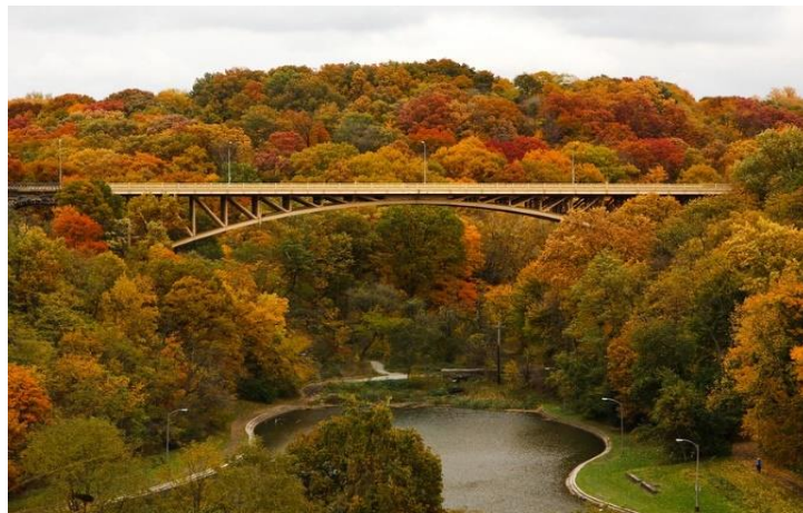
Slika 3.4. Panther Hollow Bridge, SAD (čelični trozglobni luk) [10]
