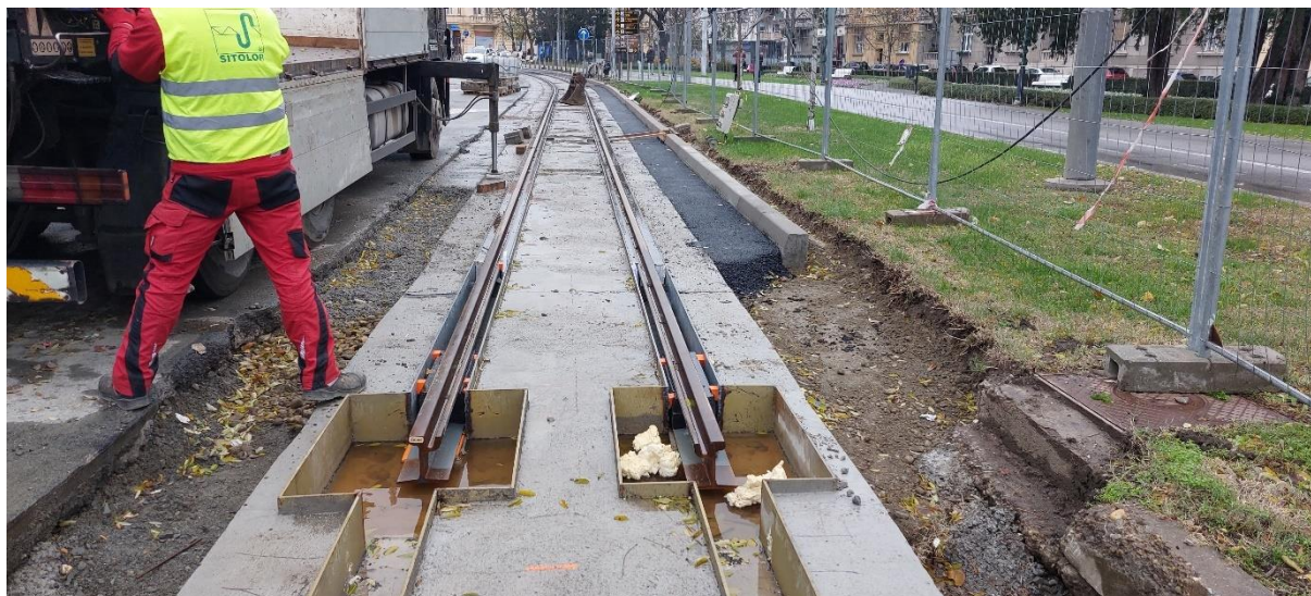
Slika 19.: Ugradnja tračnica ERS sustavom u Osijeku
