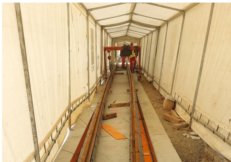
Slika 20.: Zaštita kolosijeka šatorima
