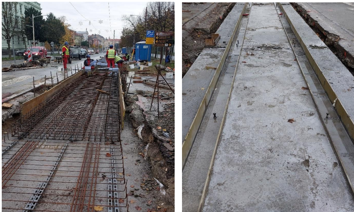
Slika 18.: Postavljanje AB ploče u Osijeku
