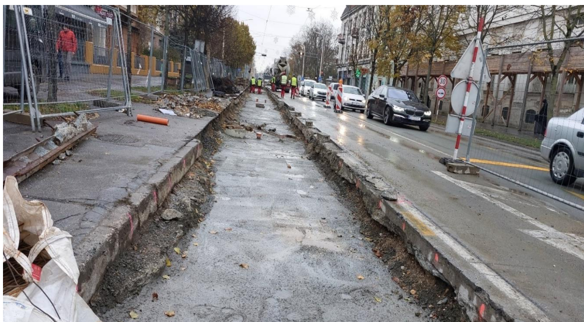
Slika 16.: Postavljanje posteljice u Osijeku
