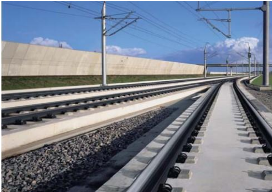
Slika 4.: Kolosijek na čvrstoj podlozi (Izvor: [3])
