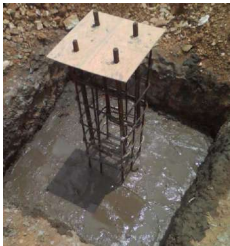
Slika 20: Temelj nosača povišenog spremnika
