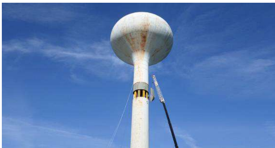
Slika 32: Montiranje spremnika na centralnom nosaču
