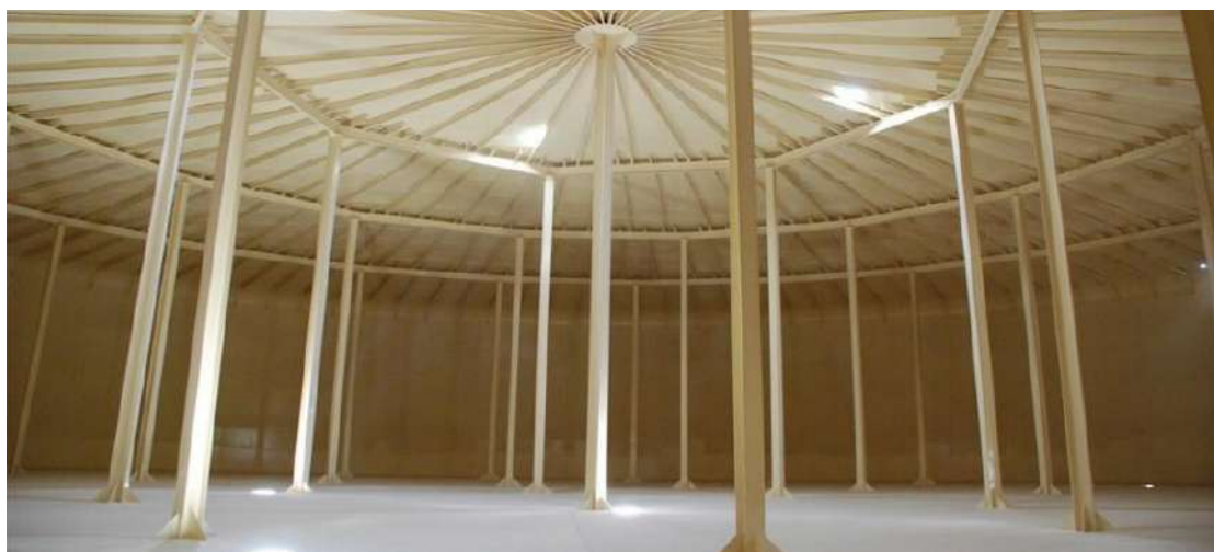
Slika 10: Unutarnji pogled na rezervoar i njegovu krovnu konstrukciju
