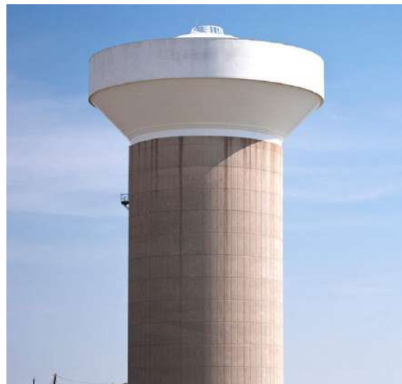
Slika 9: Kompozitni povišeni spremnik
