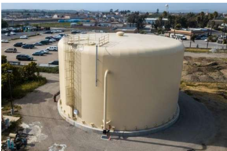
Slika 2: Zavareni rezervoar
