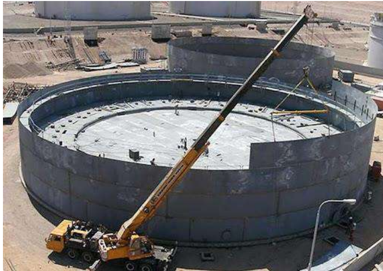
Slika 30: Sastavljanje stijenke spremnika
