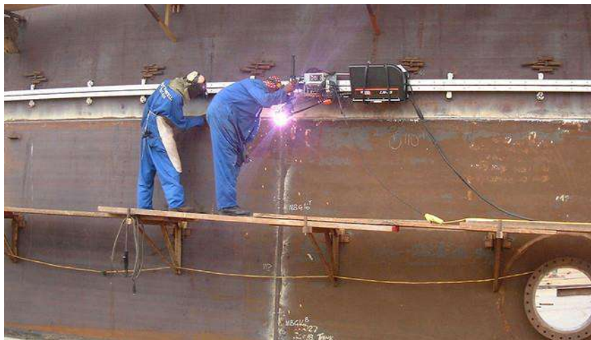
Slika 26: Zavarivanje dijelova spremnika
