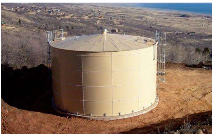
Slika 1: Rezervoar sastavljen vijcima
