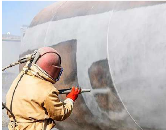
Slika 22: Pjeskarenje
