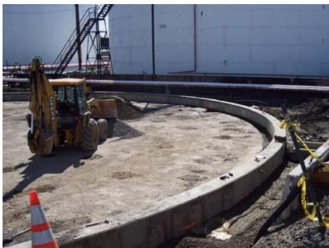
Slika 19: Temelj u obliku betonskog prstenastog zida
