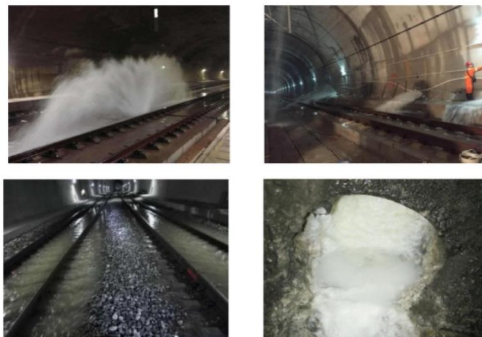
Slika 17 A) Ulazak vode u tunel, B) Ulazak vode kroz bočne zidove, C) Nagomilavanje vode na posteljici, D) Blokiranje drenažnog sustava pojavom leda (Izvor: [17]).
