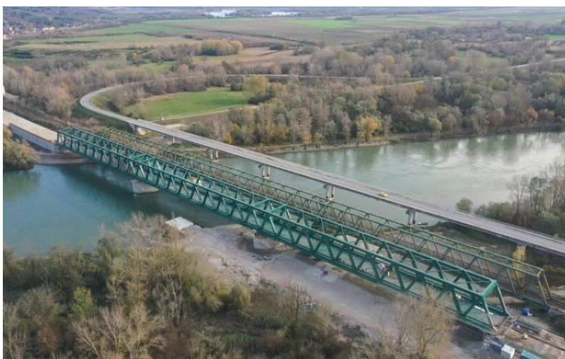
Slika 33. Željeznički most Drava na Botovu [14]
