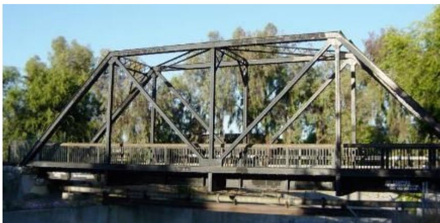
Slika 4. Rešetkasta konstrukcija u mostogradnji [8]
