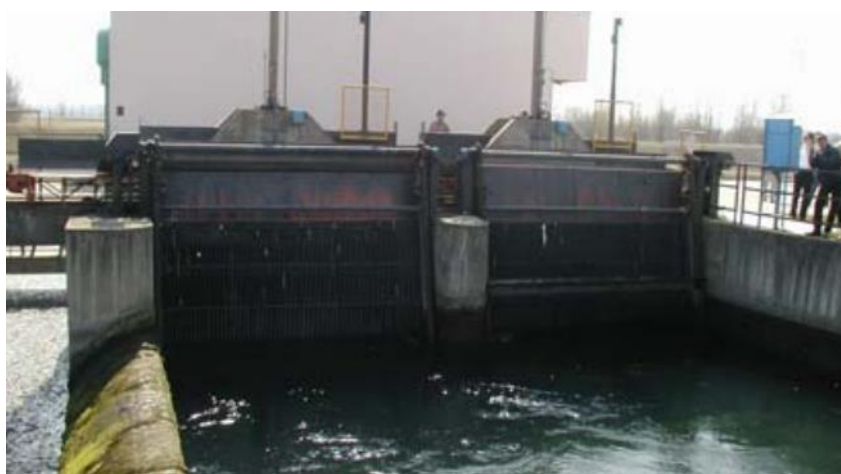
Slika 7.: Pločasti zatvarači na ulazu u malu HE Varaždin [6]
