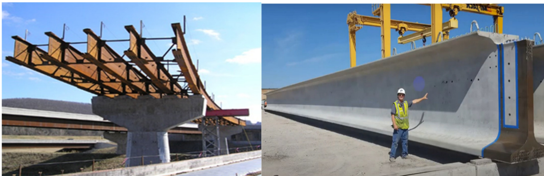
Slika 2: I-gredni nosač [5]
