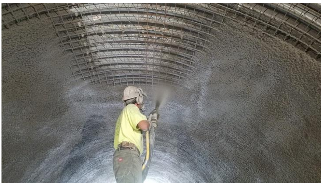
Slika 5.: Nanošenje mlaznog betona nakon postavljenih čeličnih mreža (Izvor:[16])
