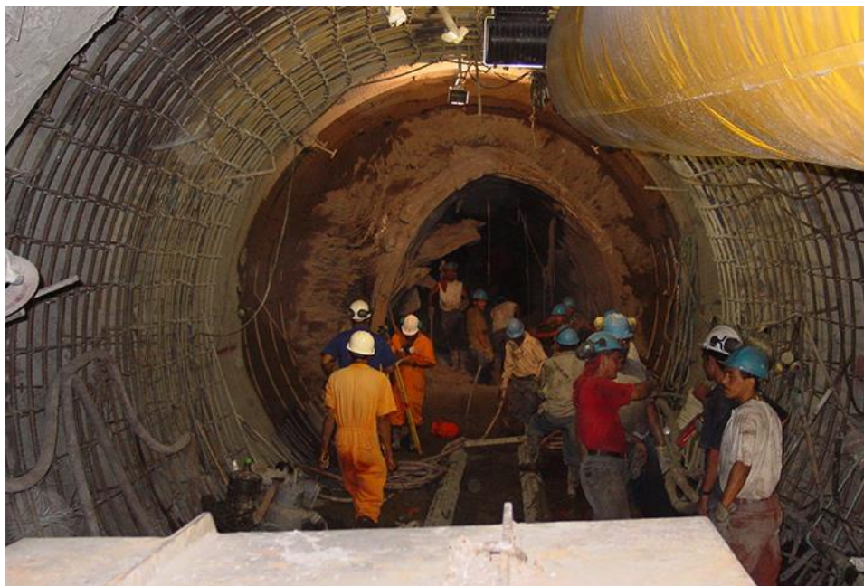
Slika 12.: Kolaps tunela Yacambú-Quibor (Izvor: [28])
