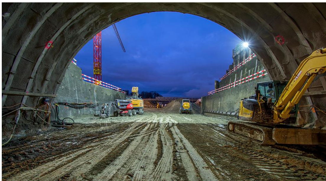
Slika 2.: Izvedena primarna podgrada (Izvor:[9])
