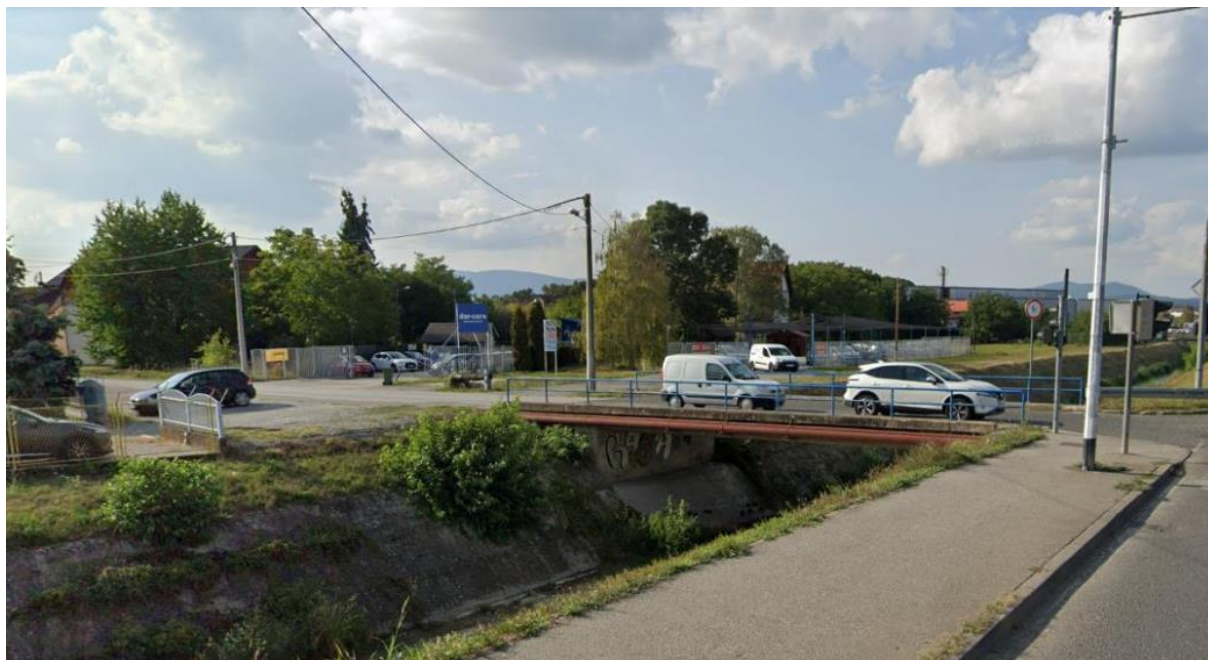
Slika 22.: Postojeći most preko potoka Vuger (Izvor: [17])
