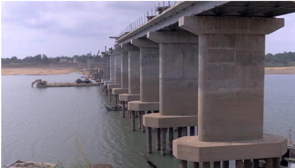
Slika 2.: Temeljenje upornjaka mosta na pilotima (Izvor: [7])
