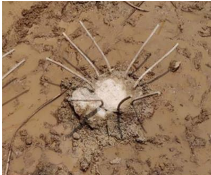
Slika 59.: Glava pilota spremna za ispitivanje cjelovitosti (Izvor: [31])
