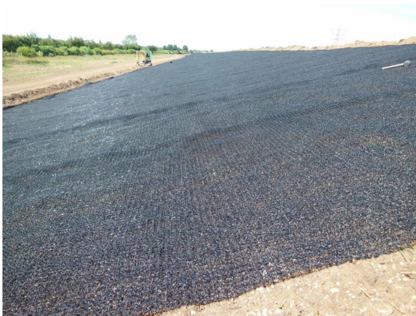
Slika 5 Postavljanje geosintetika na pokos nasipa [5]
