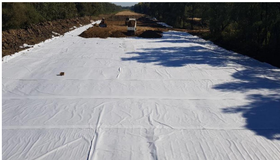
Slika 6 Ugradnja geosintetika u horizontalnim slojevima [5]
