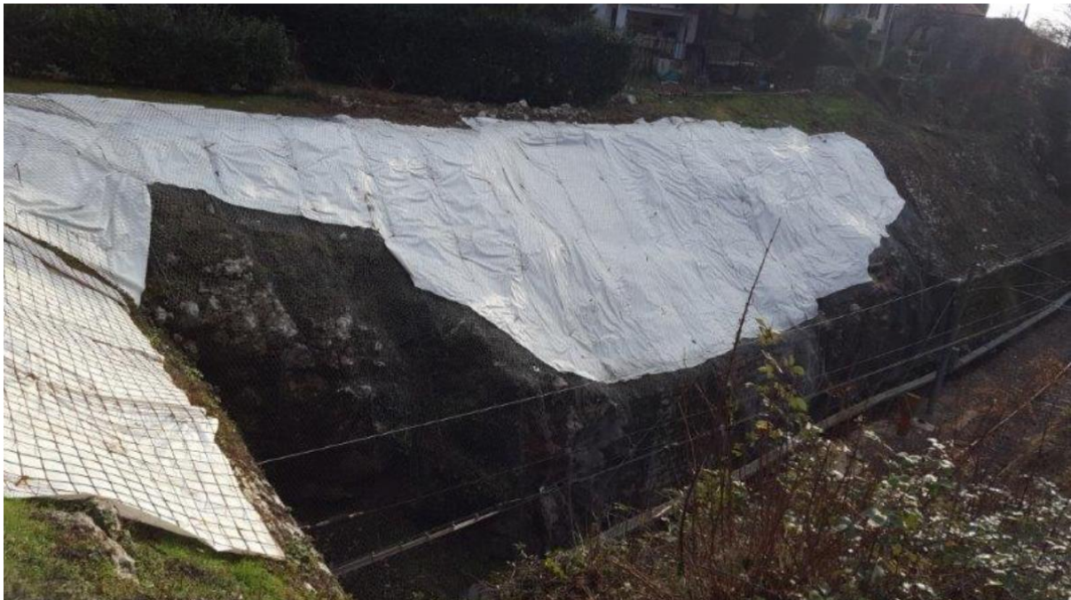
Slika 3: Postavljanje geotekstila [1]
