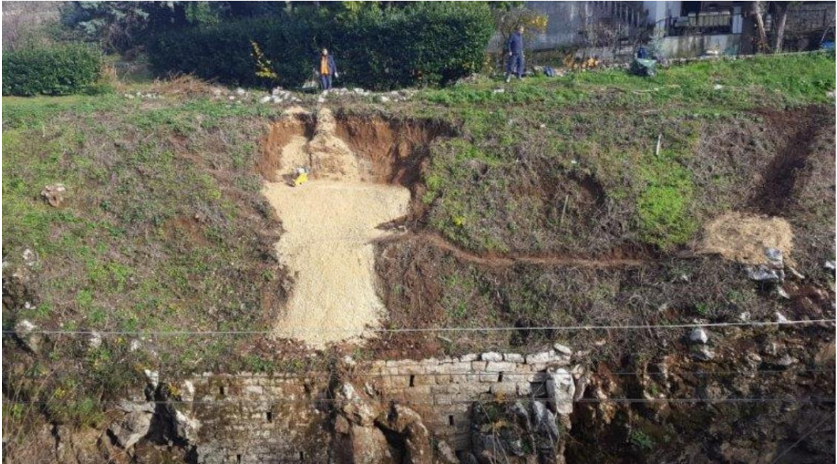
Slika 2: Dopuna materijalom na mjestu otklizanog materijala [1]
