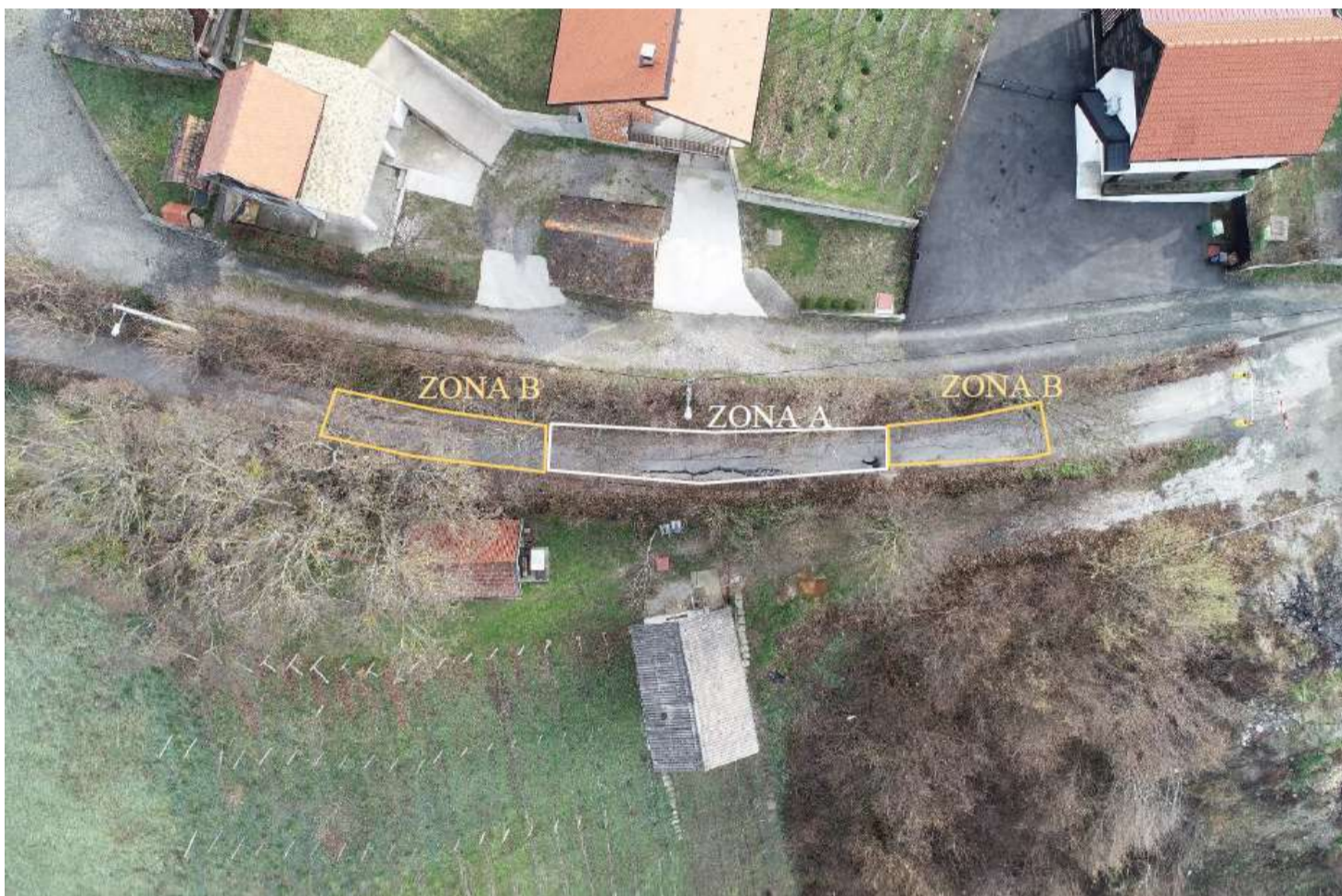
Slika 17 Zone sanacije u ulici Đurini (Izvor: [1])
