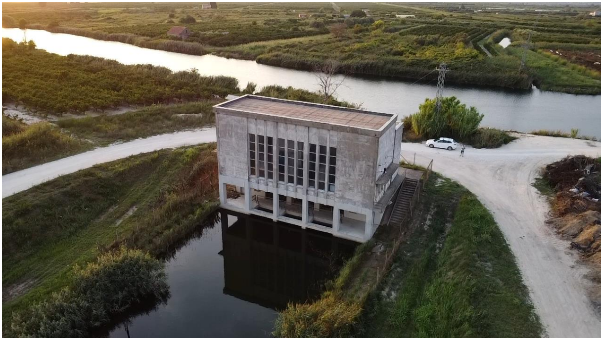
Slika 40: Crpna stanica Prag
