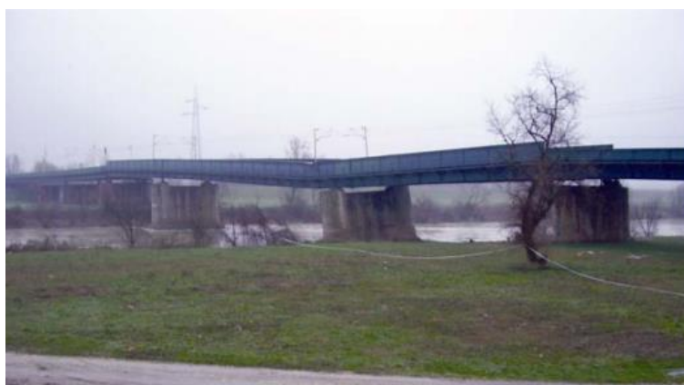
Slika 1.: Željeznički most Jakuševac (Izvor: [3])
