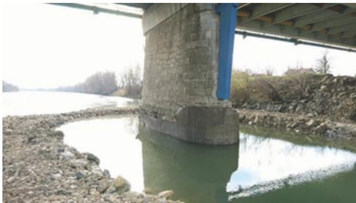
Slika 2. Sanacija temelja stupa mosta zbog podlokavanja
