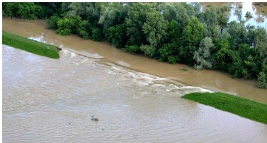
Slika 6: Pucanje nasipa kod Rajeva Sela [14]
