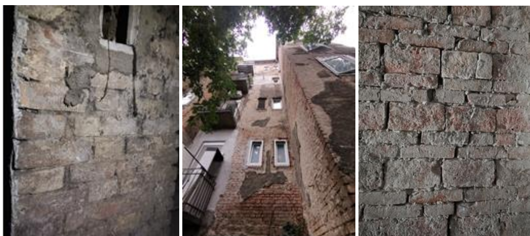
Slika 25 Zidovi a) podruma, b) dvorišnog pročelja, c) ulaznog stubišta [30]
