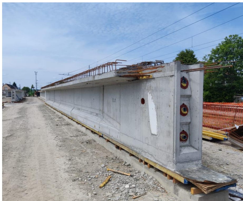
Slika 59 Prikaz predgotovljenih prednapetih nosača "T" oblika
