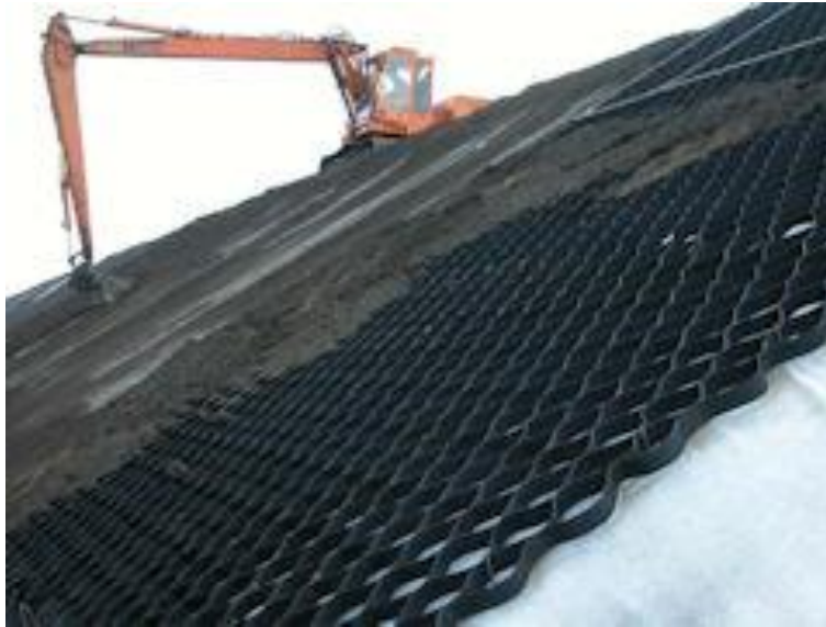
Slika 51 Ugradnja geomreža (Slika preuzeta s [ http://www.geotekstili.com/geosace.asp ])
