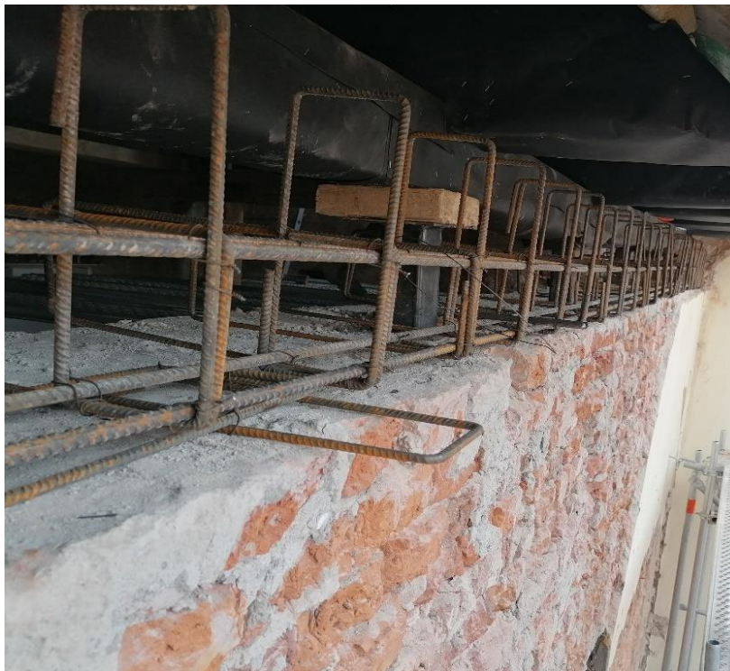
Slika 47. Armiranje horizontalnog serklaža oko drvene grede nazidnice
