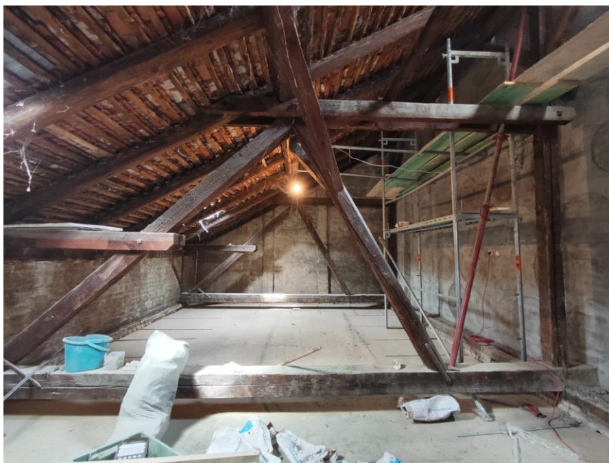
Slika 76. Konstrukcija krovišta u Mrazovićevoj 7
