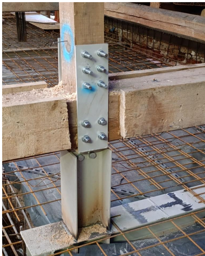
Slika 53. Prihvatanje vezne grede i drvenog stupa konstrukcije
