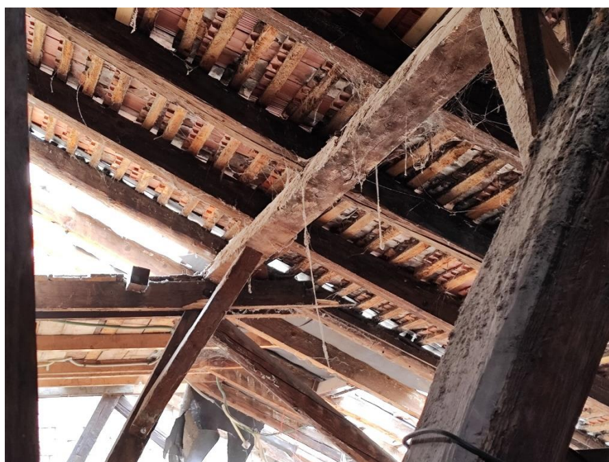
Slika 77. Kosi stupovi konstrukcije krovišta
