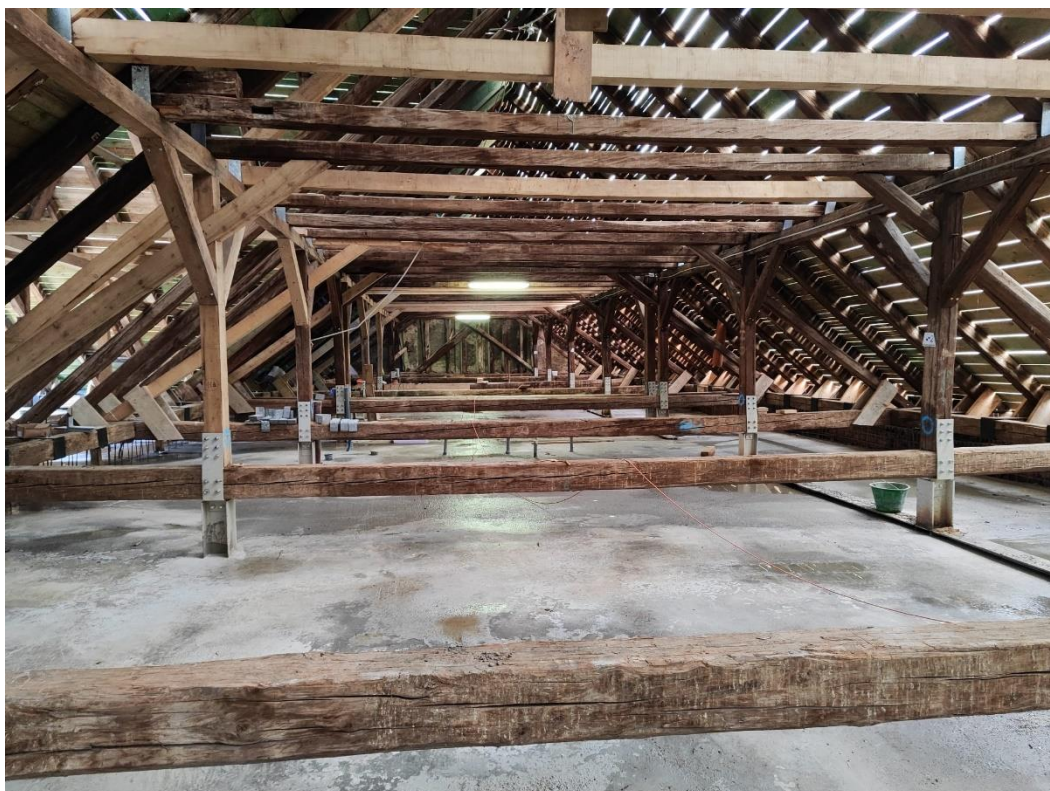
Slika 54. Izbetonirana AB ploča potkrovlja
