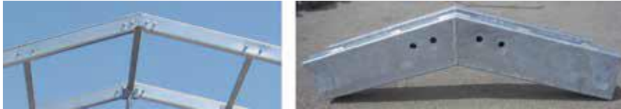
Slika 6: Priključak prečka - prečka s čeličnim umetkom [5]
