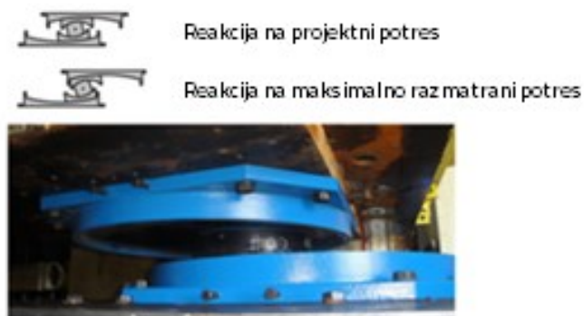
Slika 2.10 Ležaj seizmičke izolacije s trenjem njihala (Sarkisian, et al. 2013.)
