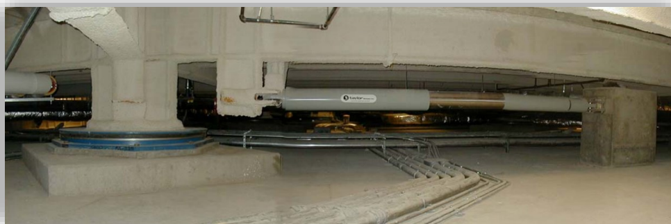
Slika 6.2 Klizni ležaj i hidraulički prigušivač (Kircher, 2013.)
