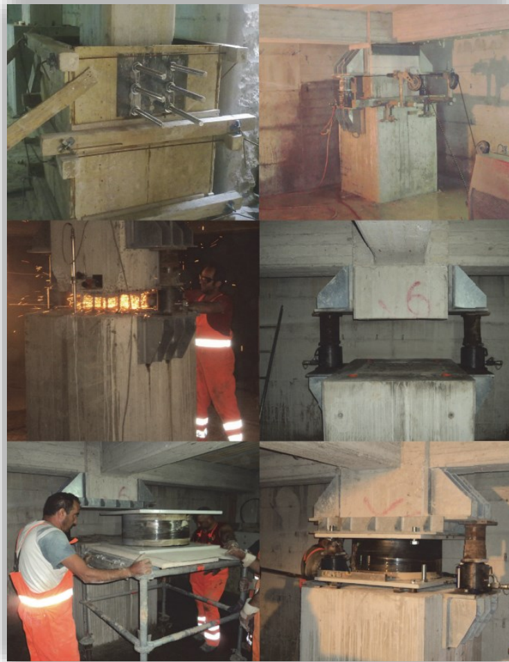
Slika 6.4 Postupak ugradnje izolacijskih ležajeva pri rekonstrukciji bolničkog centra u Avellinu (Ferraioli, Mandara, 2017).
