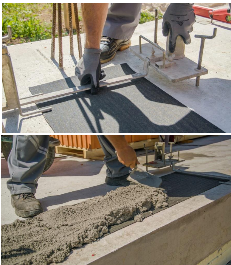
Slika 24. Postavljanje hidroizolacije (gore) i postavljanje morta (dolje) (Izvor: [29])
