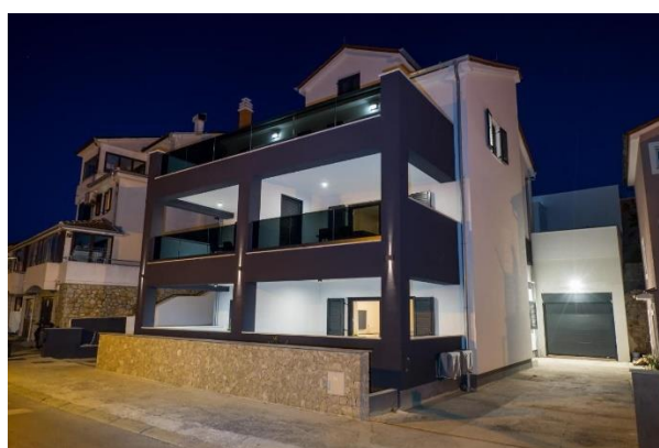
Slika 34. U potpunosti izgrađena obiteljska kuća
