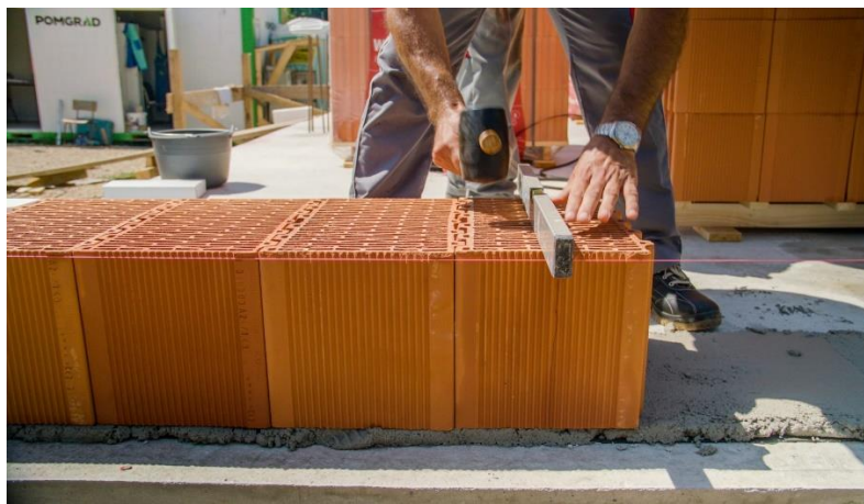
Slika 25. Zidanje prvog reda (Izvor: [29])
