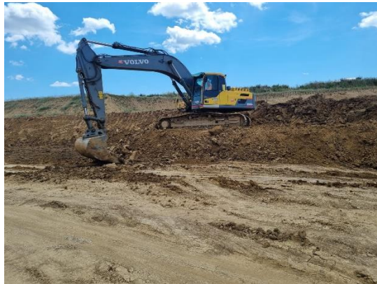
Slika 6. Strojni iskop gline (Izvor: [11])
