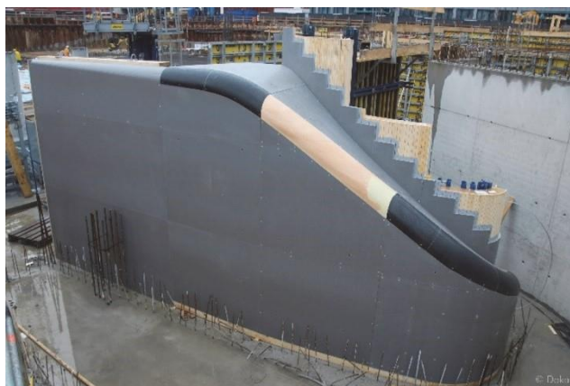
Slika 1.: 3D ispisana oplata stubišta [1]
