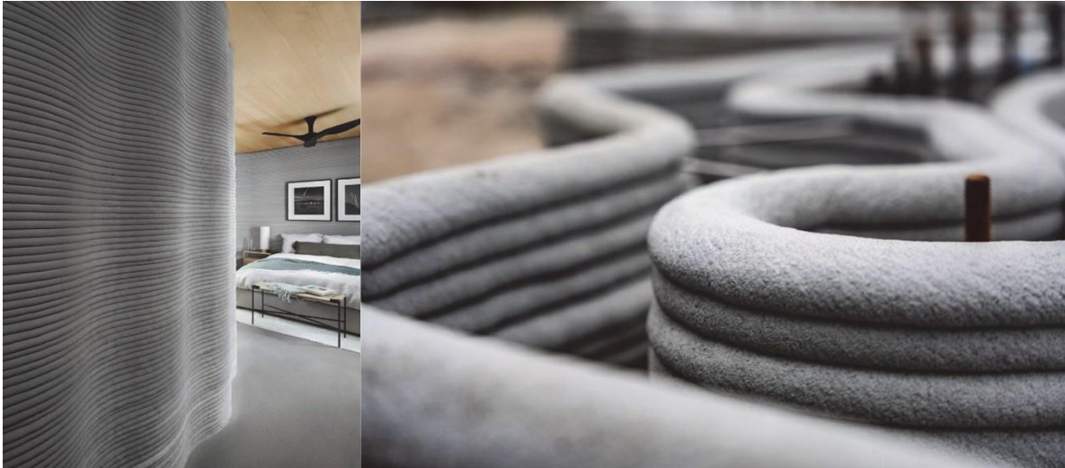
Slika 18.: Detalj zida i njegova 3D izvedba [17]
