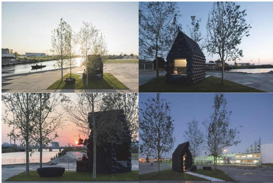
Slika 15.: Canal House – Amsterdam [14]
